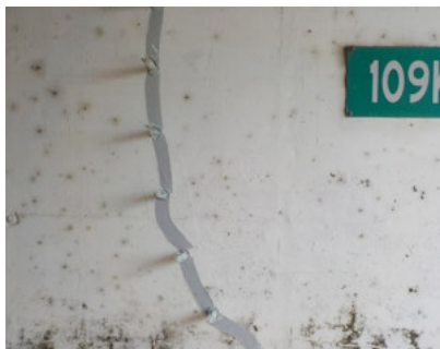
注射工法於結構裂縫補強的注射
