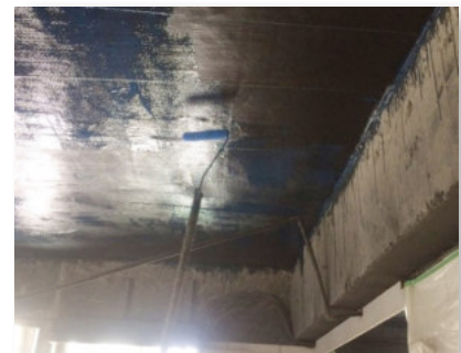
樓板以破纖貼片與環氧樹脂積層補強
