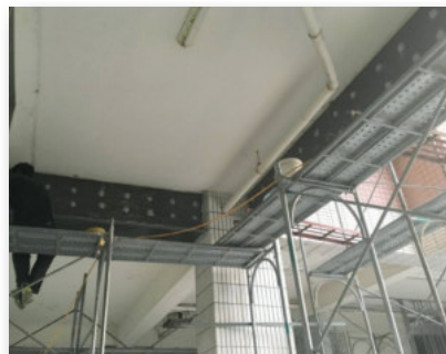
鋼板補強用於建築物樑損傷
